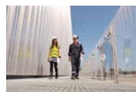
Imposant: die Anlagen in Plymouth und Ridham Dock
